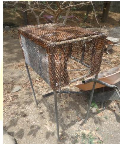
Foto 6 y 7 cajas filtro en mal estado
