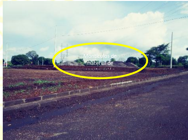
Imagen 2. Se observa que el proyecto inició actividades de construcción tales como cunetas, terraceo, instalaciones eléctricas, movimientos de tierra, construcción de calles
