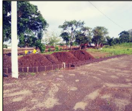
Imagen 6 Movimientos de tierra dentro del área del proyecto
