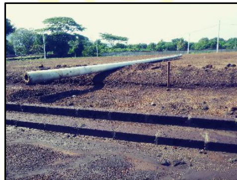
Imagen 4. Postes de tendido eléctrico listos para la interconexión
