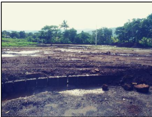
Imagen 3. Rotonda interna en construcción
