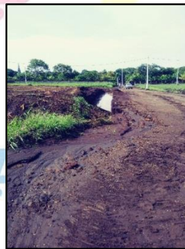
Imágenes 9, 10 y 11. Derrumbe en las zanjas y agua acumulada en zanjas
