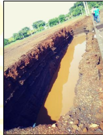
Imagen 8. Zanjas artesanales Lotificación Ticuantepe con agua de lluvia estancada
