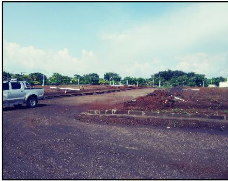
Imagen 5 Construcción de calles en el emplazamiento del Proyecto
