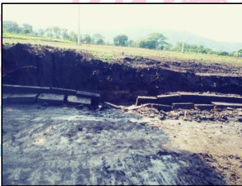
Imágenes 9, 10 y 11. Derrumbe en las zanjas y agua acumulada en zanjas
