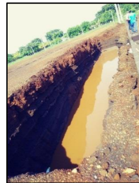
Imágenes 9, 10 y 11. Derrumbe en las zanjas y agua acumulada en zanjas
