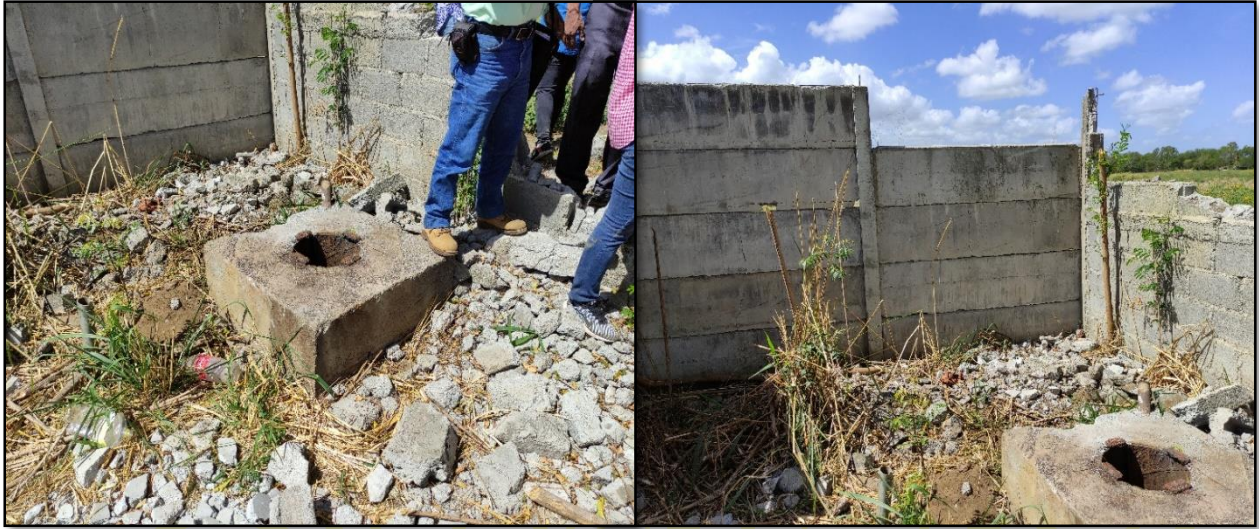
Figura 3 Pozo artesanal en estado de abandono dentro del área del proyecto.
