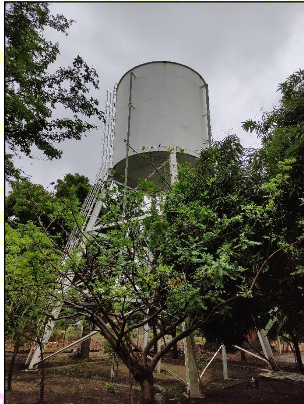
Figura 10 Tanque de Almacenamiento sobre torre
