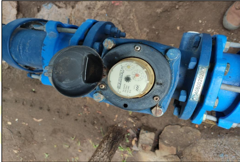
Figura 4 Dispositivo para la medición de volúmenes extraídos del pozo
