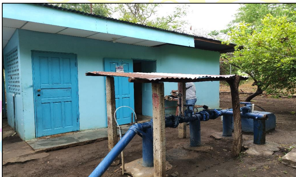
Figura 3 Sistema de bombeo y cloración en funcionamiento
