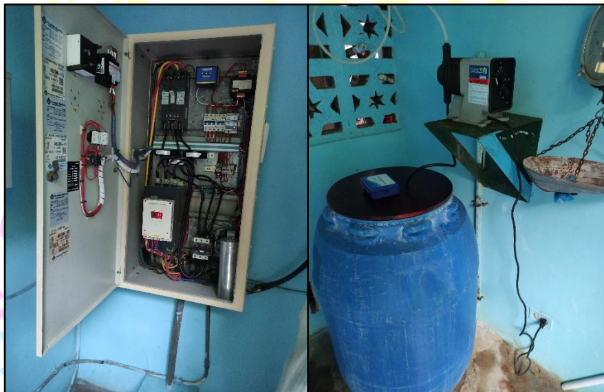
Figura 9 Equipos eléctricos instalados en la caseta
