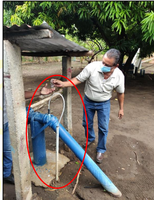
Figura 8 Tubería de desinfección en la sarta
