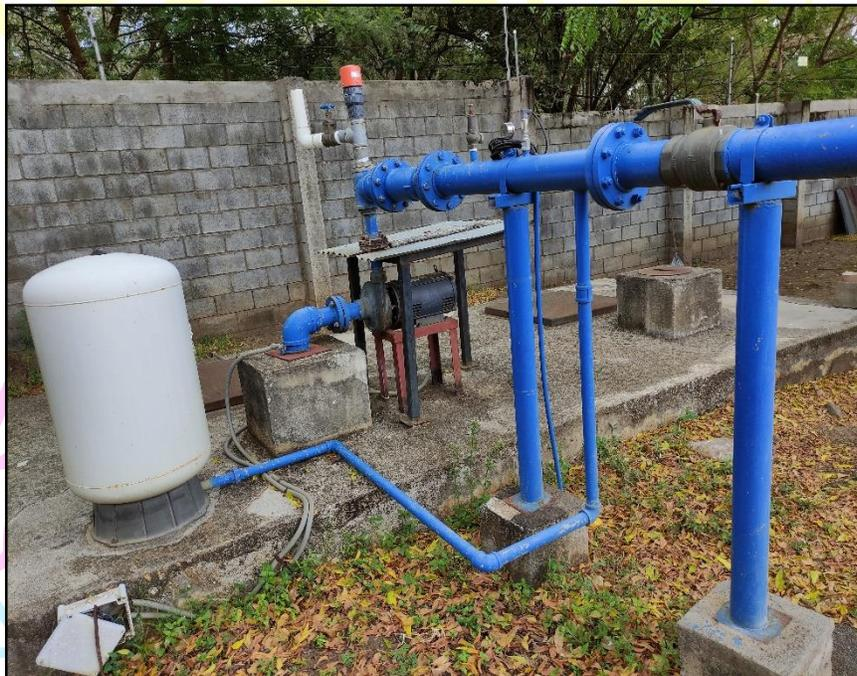
Figura 9 Sistema de almacenamiento sobre el suelo
