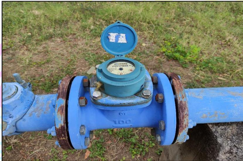
Figura 4 Medidor de lectura de volumen m<sup>3</sup>
