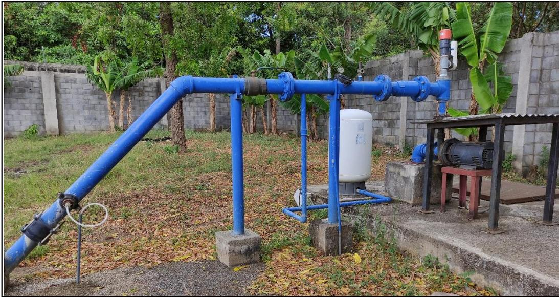
Figura 7 Conexión del clorinador antes del sistema de almacenamiento
